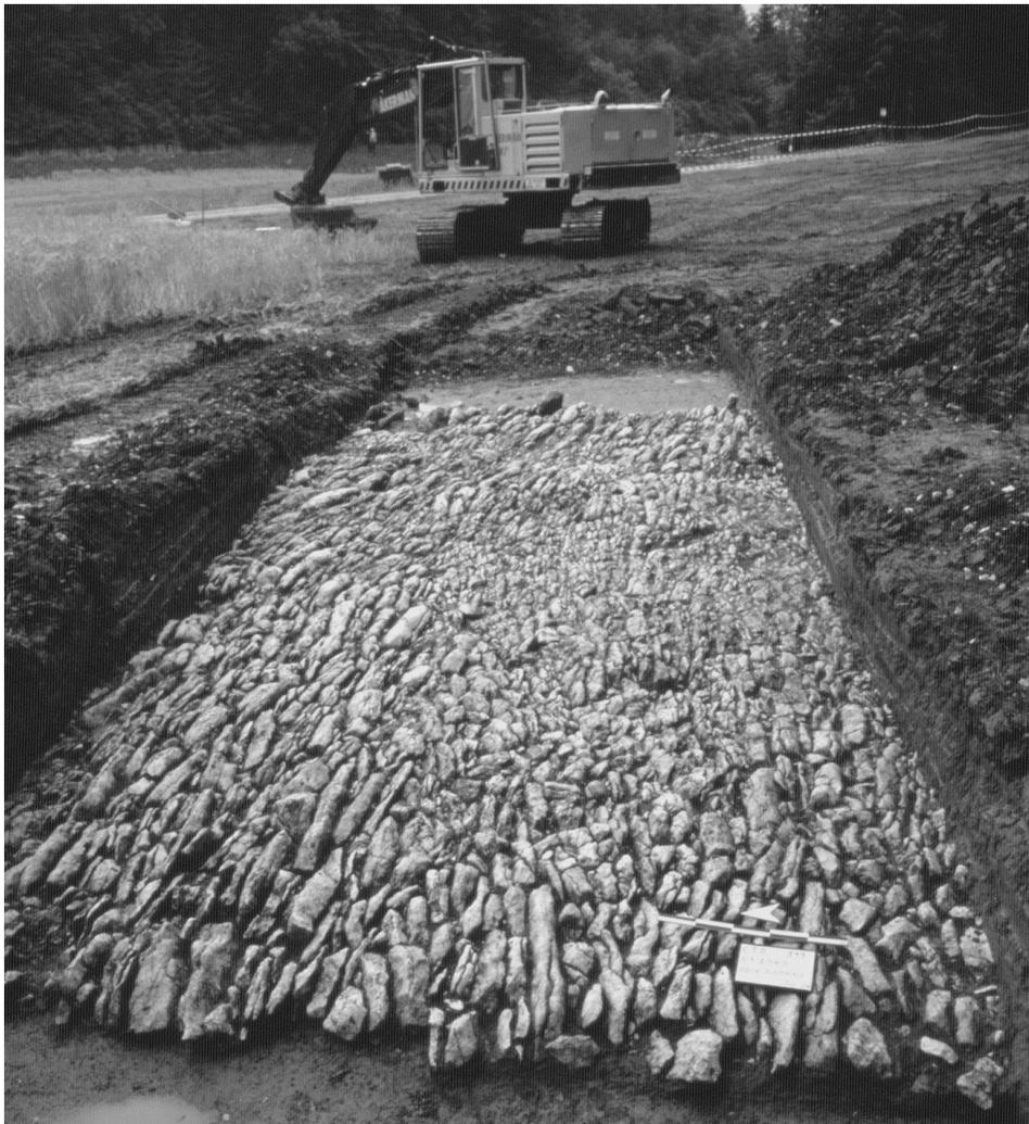
*Fig. 3. Courtedoux, combe Vâ Tché Tchâ. Segment de voie romaine. A l'origine, elle était recouverte d'une couche de gravier compacté. Largeur : 6,70 m. © OCC/SAP, Porrentruy*
